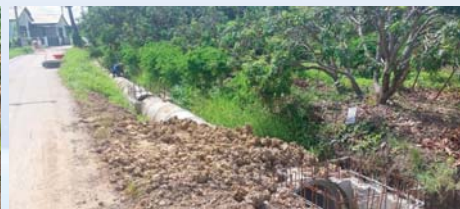
โครงการวางท่อระบายน้ำคอนกรีตเสริมเหล็กพร้อมบ่อพักบริเวณบ้านนางจันทร์สม พองศรี ถึงบ้านนางเพิ่มทอง แสนศรี หมู่ที่ 7 บ้านทุ่งแดง
