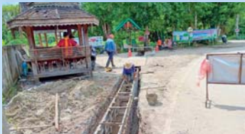
โครงการก่อสร้างรางระบายน้ำคอนกรีตเสริมเหล็กพร้อมฝาดปิด คอนกรีตเสริมเหล็ก บริเวณบ้านนายสมเพชร แสงปัญญา ถึงสะพานบุญ หมู่ที่ 5 บ้านหนองแฟก
