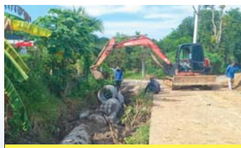
โครงการวางท่อระบายน้ำคอนกรีตเสริมเหล็กพร้อมบ่อพักบริเวณ บ้านนางแก้ววรรณ นามวงศ์ ถึงบ้านนายนิคม ศิริบุญร หมู่ที่ 6 บ้านทุ่งแดง
