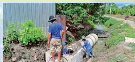
โครงการวางท่อระบายน้ำคอนกรีตเสริมเหล็กพร้อมบ่อพักบริเวณบ้านนายวัลลภ แสงเดช หมู่ที่ 5 บ้านหนองแฟก
