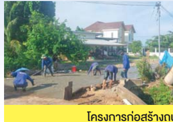
โครงการก่อสร้างถนนคอนกรีตเสริมเหล็ก บริเวณซอย 8 หมู่ที่ 2 บ้านสันป่าสัก
