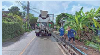
โครงการก่อสร้างรางระบายน้ำคอนกรีตเสริมเหล็กพร้อมฝาดปิด บริเวณถนนสายหลัก หมู่ที่ 9 บ้านสันป่าสัก
